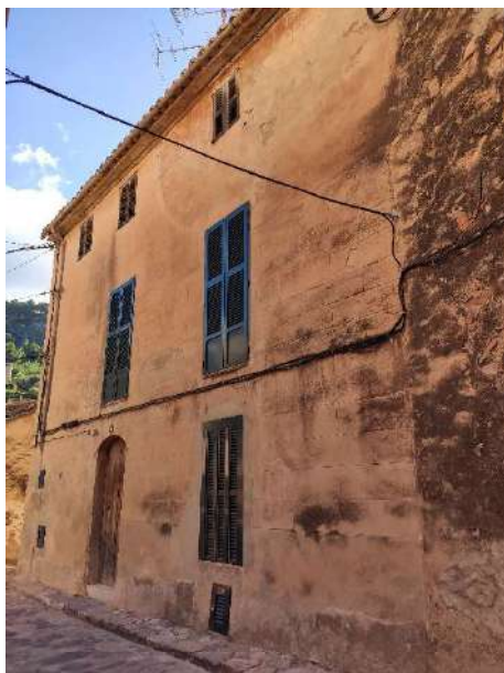
Portal principal d'arc escarser
