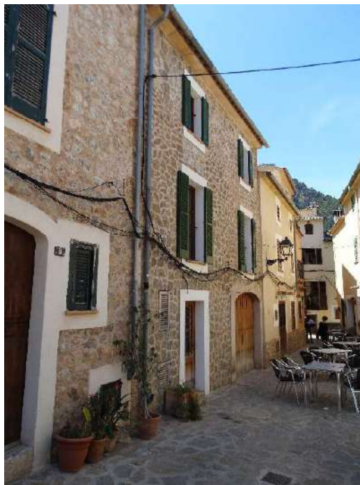
Façana principal a dos eixos
