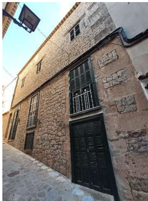
Façana del carrer Cavalleria
