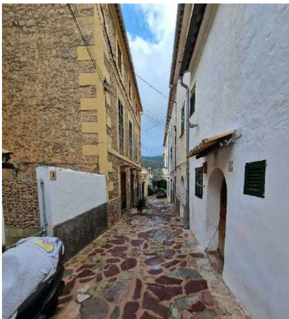
Dreta – Façana nord-oest
