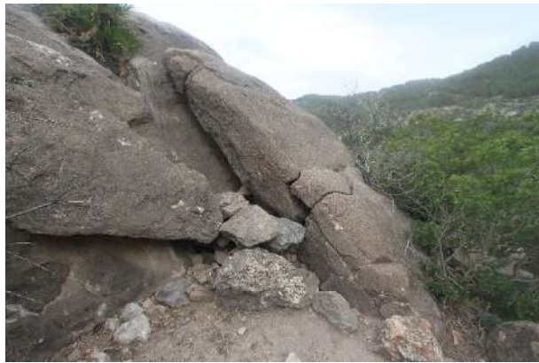
Estructura adossada a la roca
