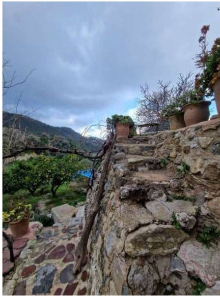
Accés a la carrera elevada de paredat
