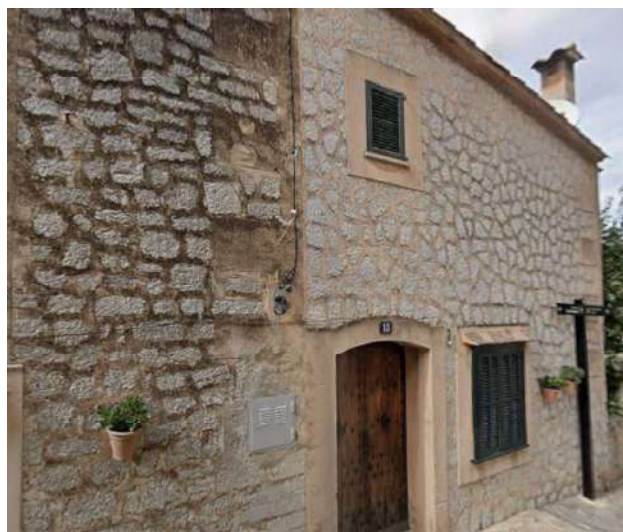
Façana est del volum de la dreta
