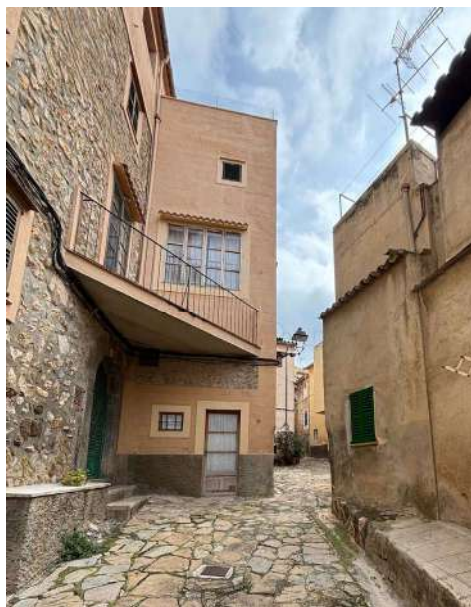
Façana nord-oest del cos adossat
