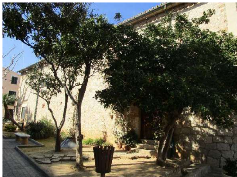
Façana lateral sud
