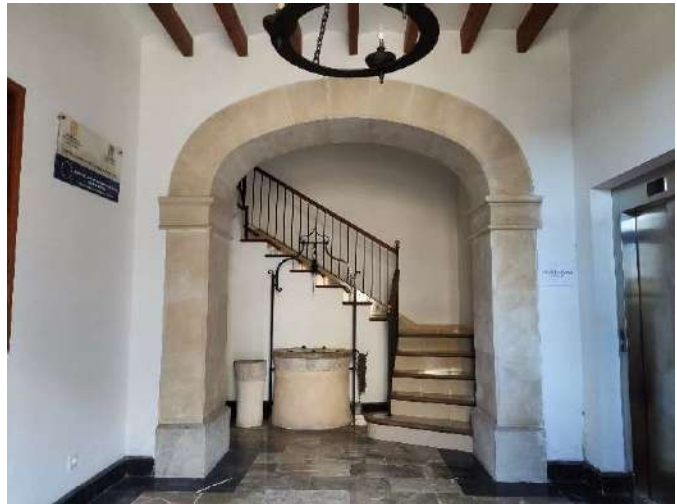
Arc rebaixat i el coll de cisterna de l'interior
