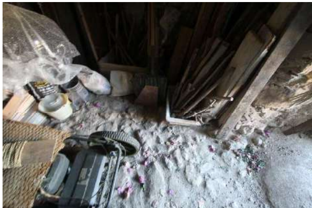
Empedrat existent a l'interior
