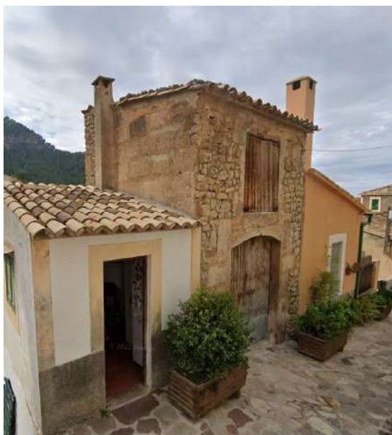
Portal escarser i finestra gran amb tancaments de fusta
