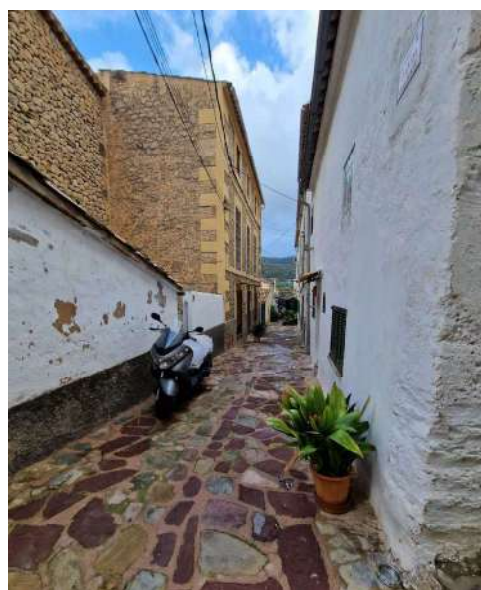
Dreta – Façana nord-oest
