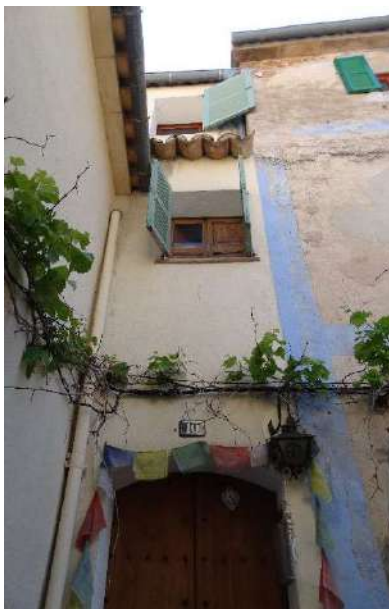
Portal d'arc escarser
