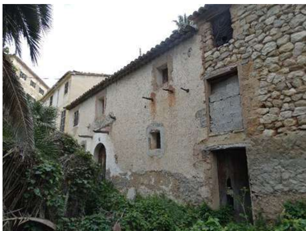
Façana principal dels dos volums mirant a oest
