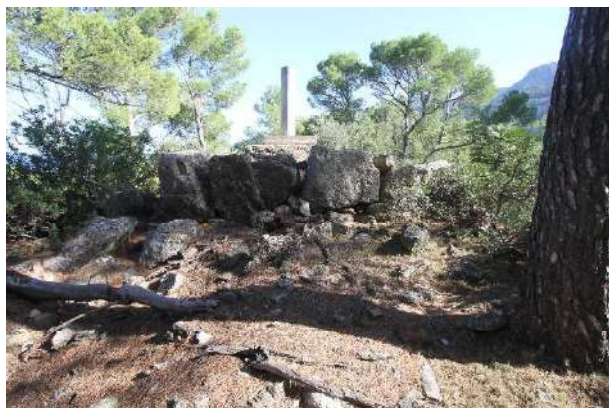
Vista de paraments ciclopis des del sud-oest
