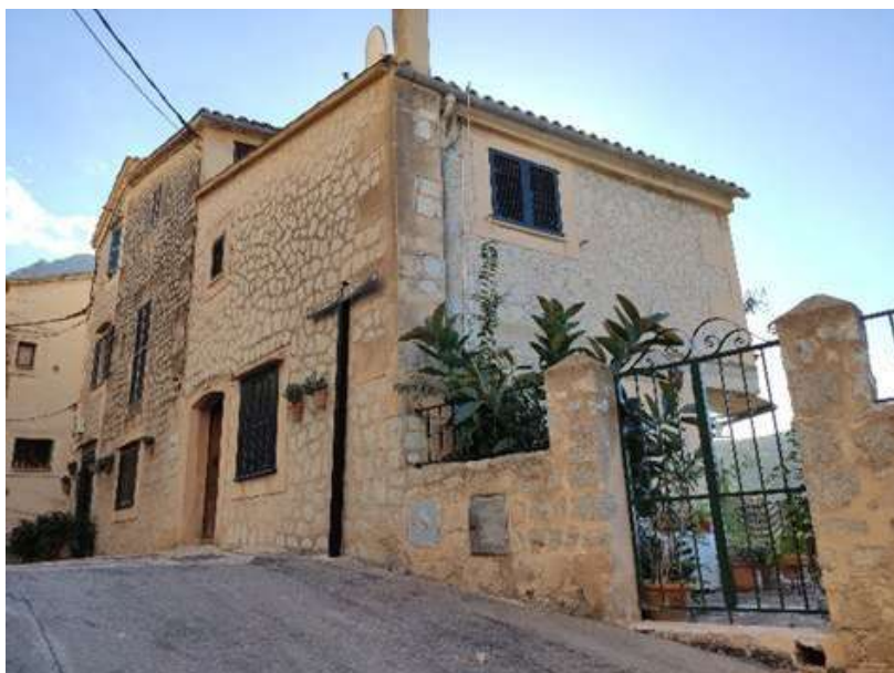
Conjunt dels dos volums amb l'accés al pati
