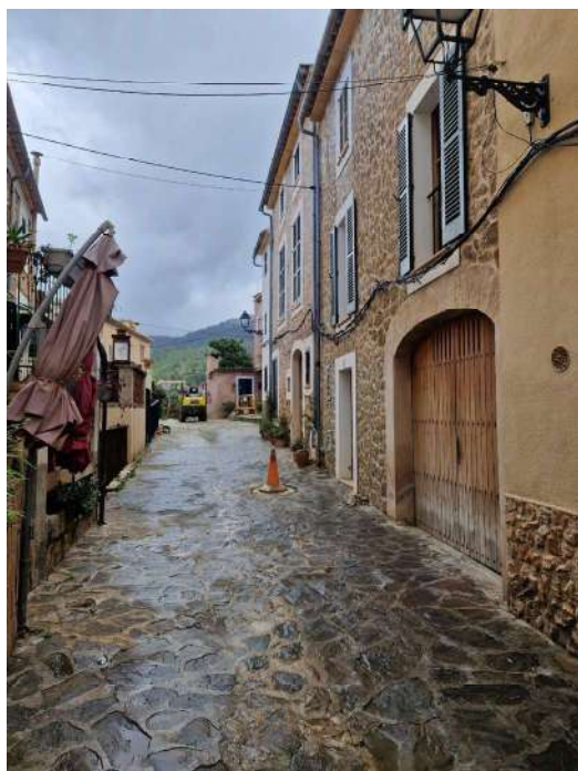
Portassa d'arc escarser
