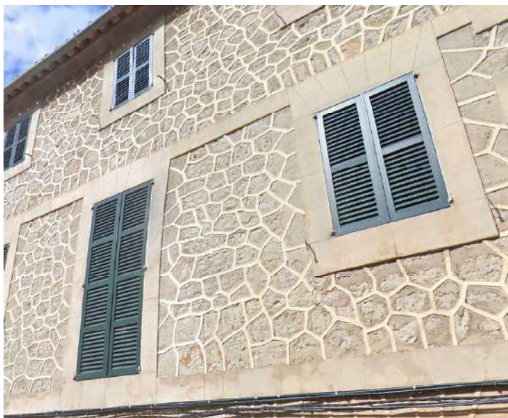
Detall del revestiment de la façana principal
