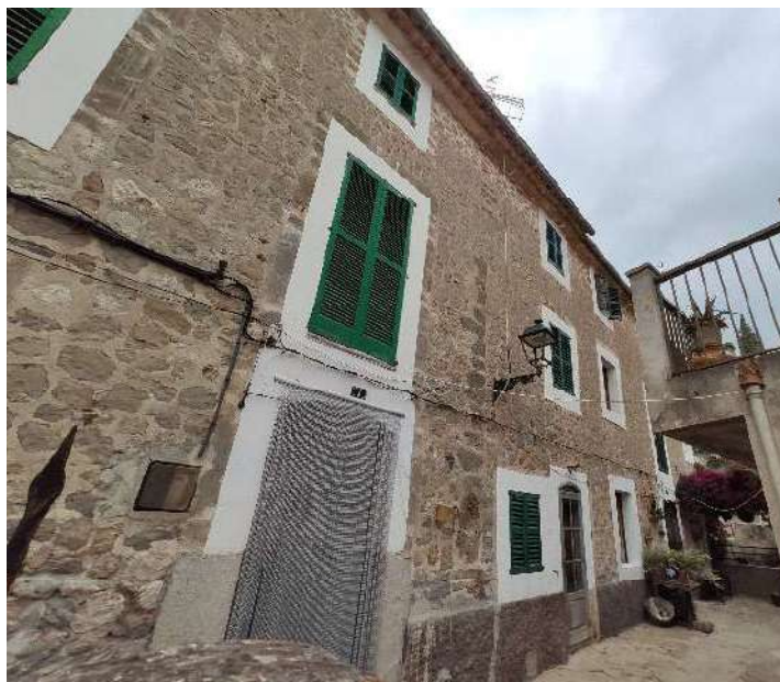
Portal d'entrada amb arc escarser
