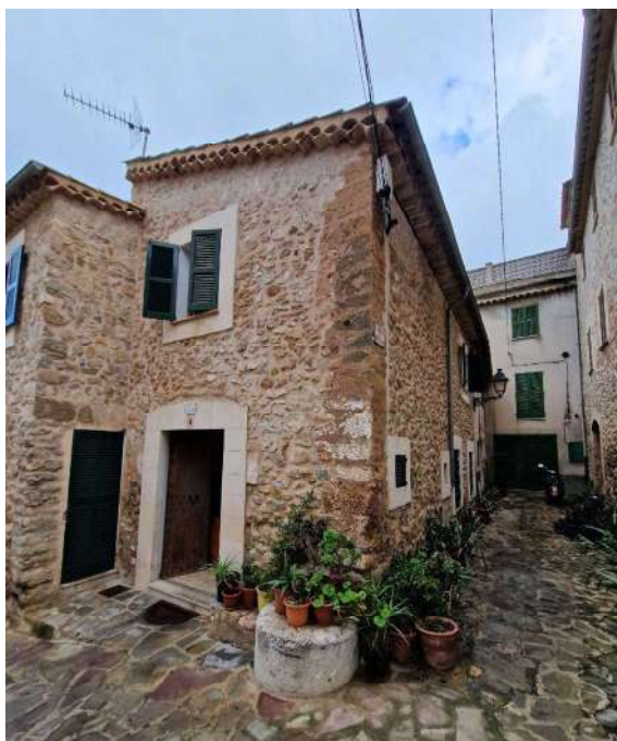
Façana principal sud-oest
