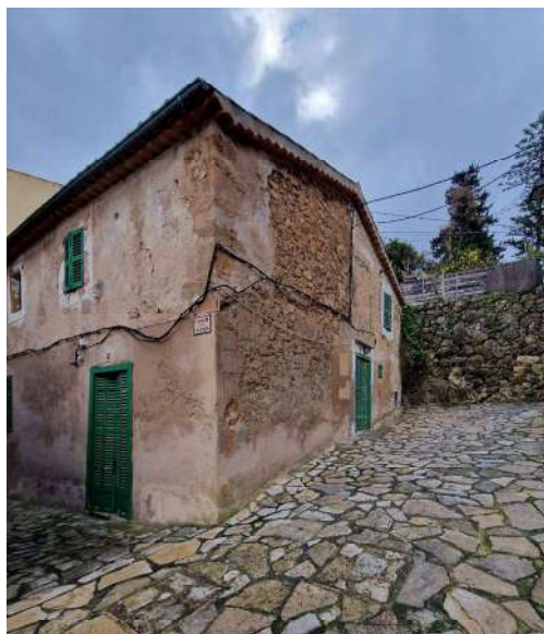
Façana lateral cega
