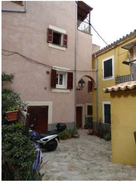
Façana nord-est i arc de reforç
