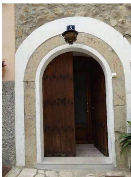
Portal d'entrada nord
