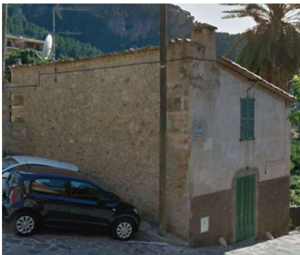
Façana posterior est i façana nord amb portal
