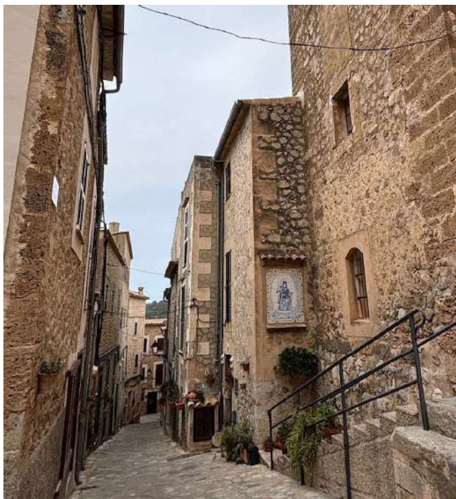
Dreta – Façana sud-oest i mosaic de rajola
