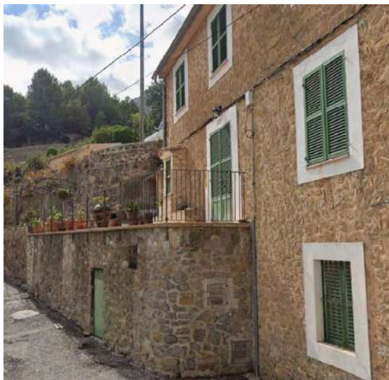
Façana est amb el cos adossat
