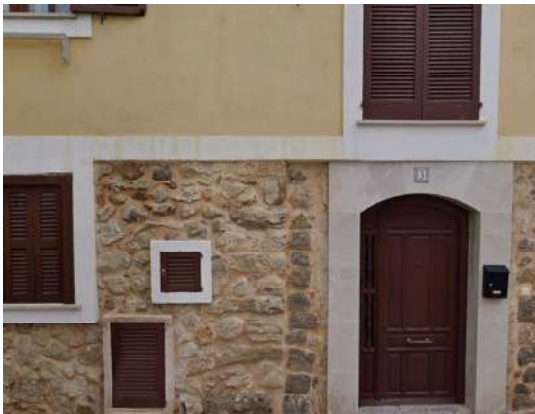
Portal d'entrada i sòcol
