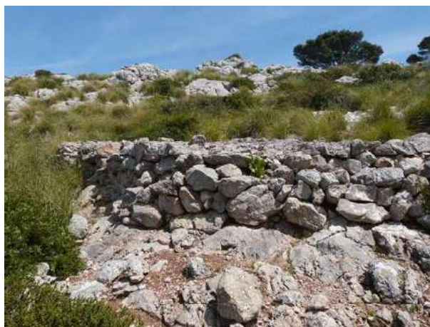
Marge de sosteniment paredat
