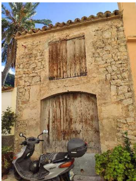
Portal escarser i finestra gran amb tancaments de fusta
