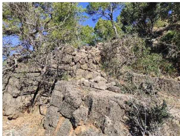
Estructures a l'entorn del jaciment
