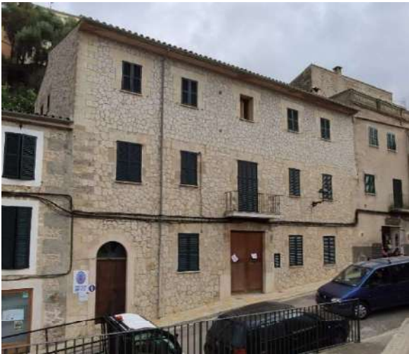
Façana principal orientada a nord
