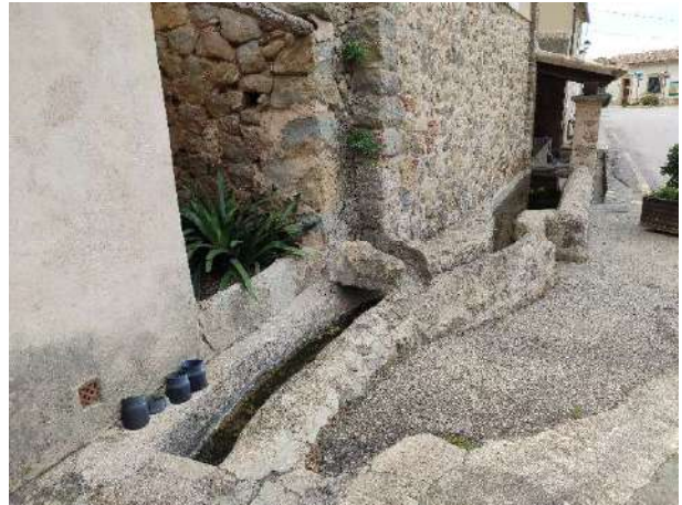
Sistema hidràulic que porta l'aigua fins a la pica
