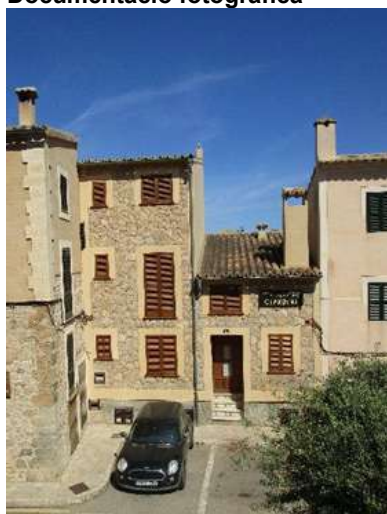
Façana sud dels dos volums
