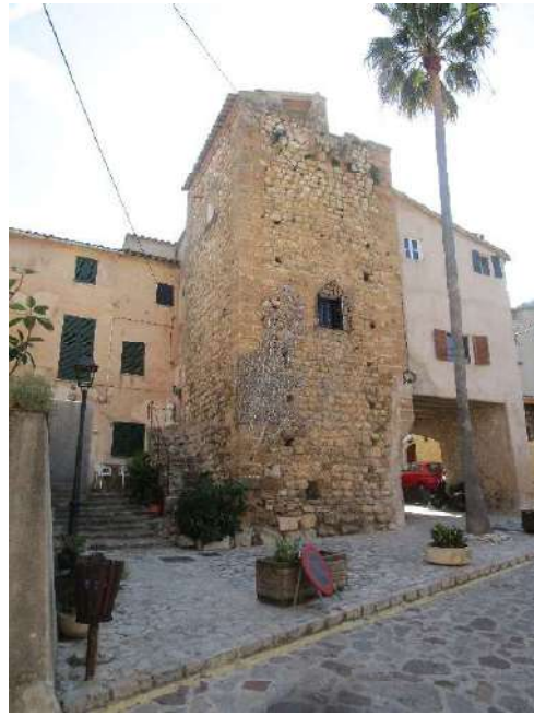
Façanes nord de la torre
