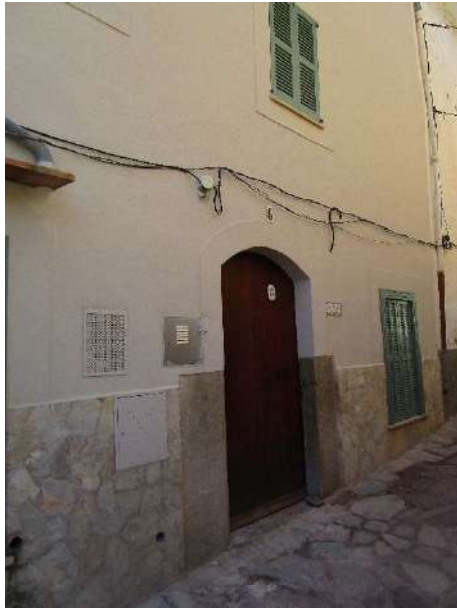
Portal d'entrada amb un arc escarser
