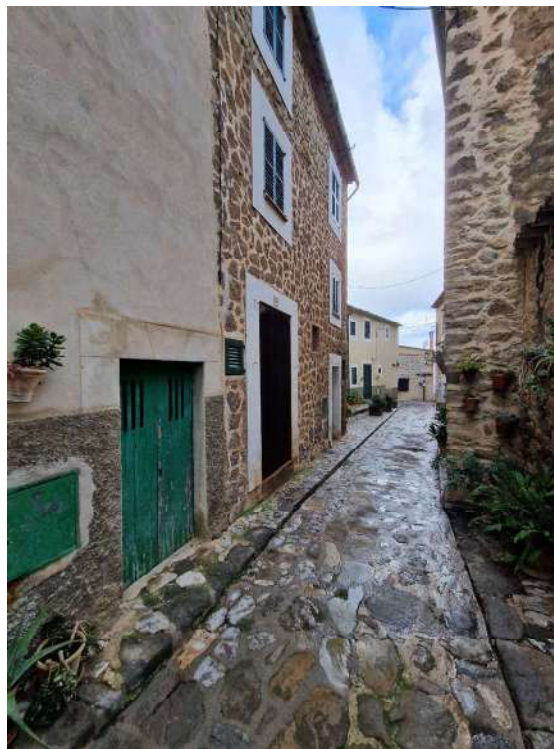
Portal d'arc escarser
