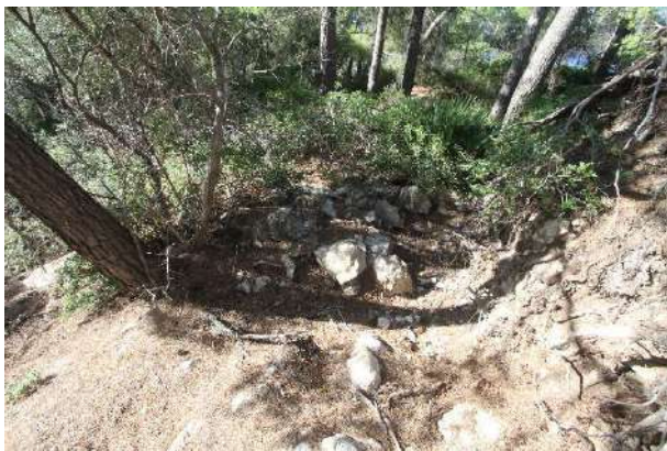
Enderrocs d'estructures escampades al voltant
