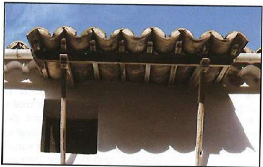
Voladís de teules amb mènsoles de fusta
