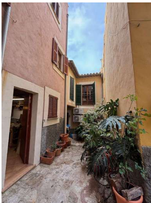
Esquerra – Façana nord-est i cul-de-sac
