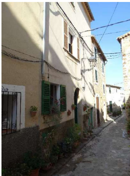
Entorn de la façana
