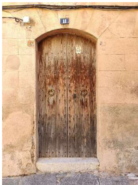
Portal principal d'arc escarser
