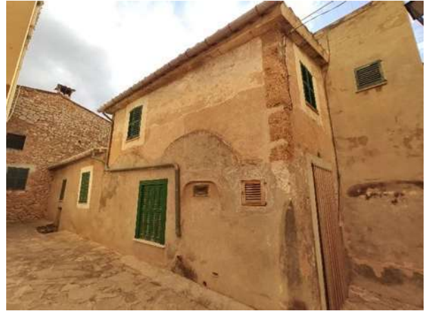
Vista de l'element des de l'est
