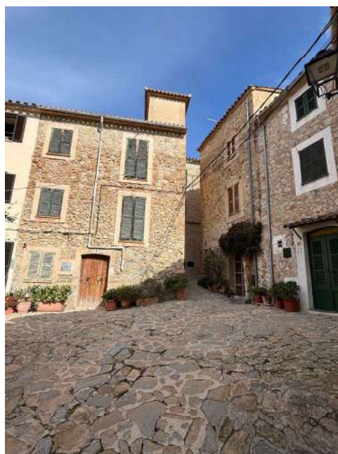
Dreta – Façana oest
