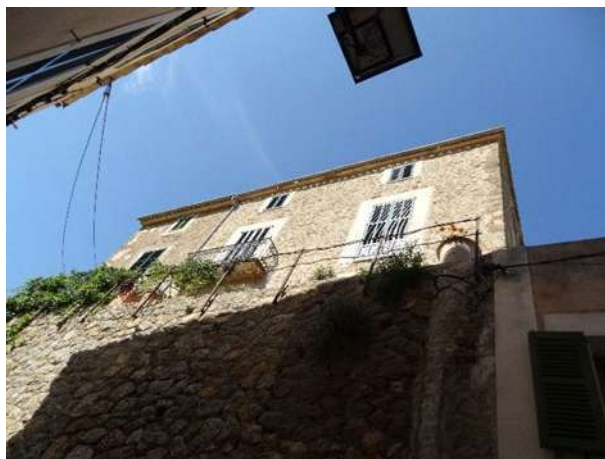
Carrera emmacada i balustrada de ferro
