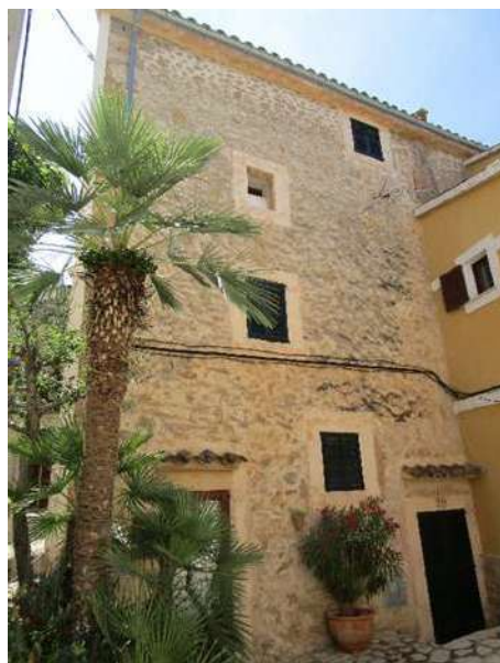
Façana nord-oest amb els voladissos
