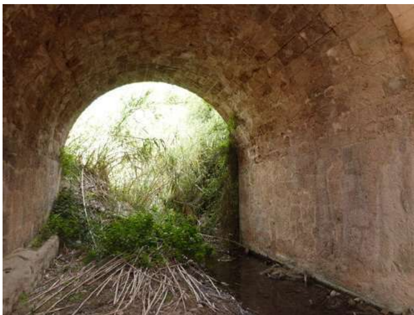
Vista de l'interior del pont
