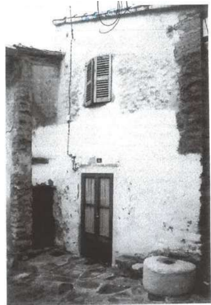
Foto històrica façana principal
