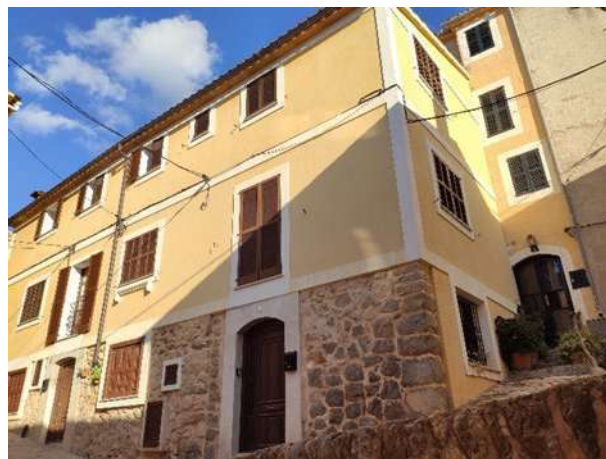
Façana principal i façana oest
