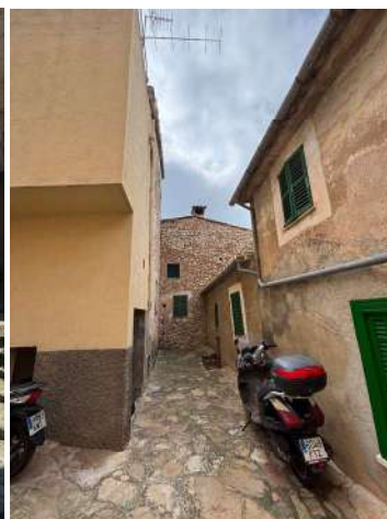
Façana posterior de paredat
