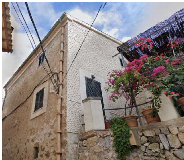
Façana oest vista des del carrer Rector Palmer
