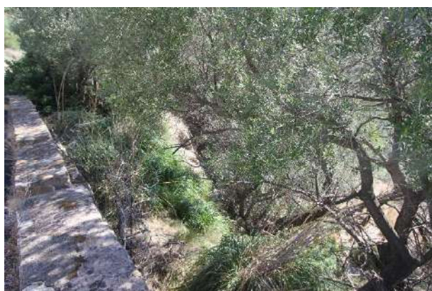
Estructures de pedra amortitzades per sota de les actuals terrasses
