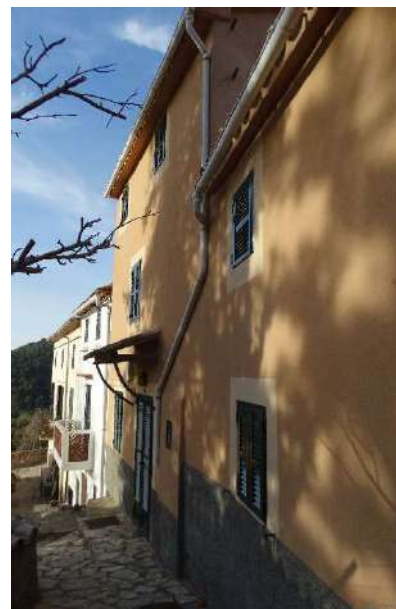
Façana principal orientada oest
