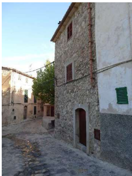
Façana principal i portal d'arc escarser
