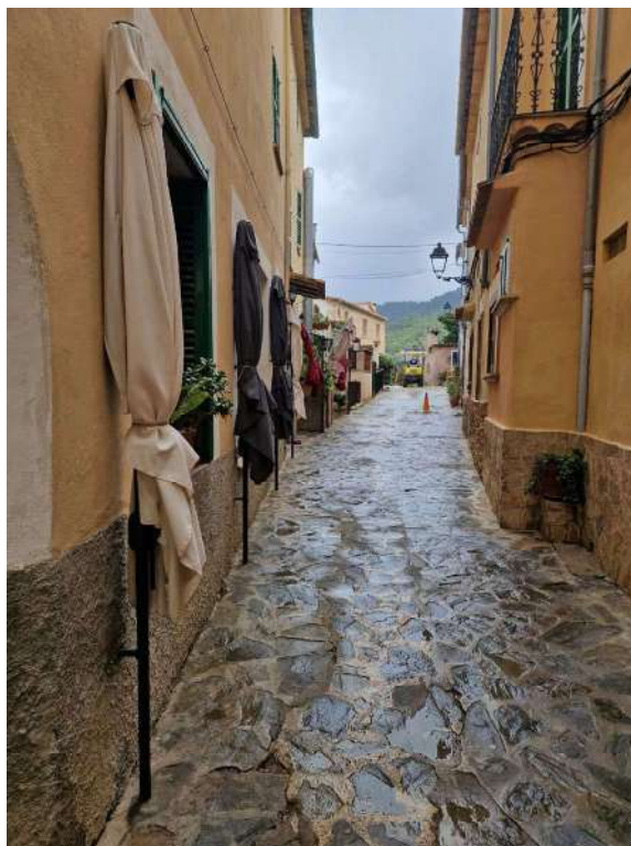
Dreta – Façana nord-oest
