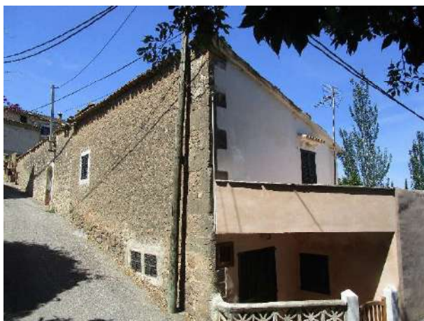
Façana paredada i cantonera cadenada
