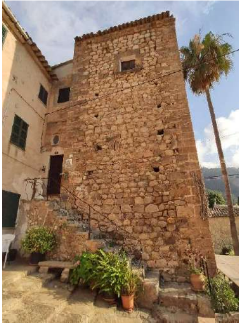
Façana nord-est de la torre
