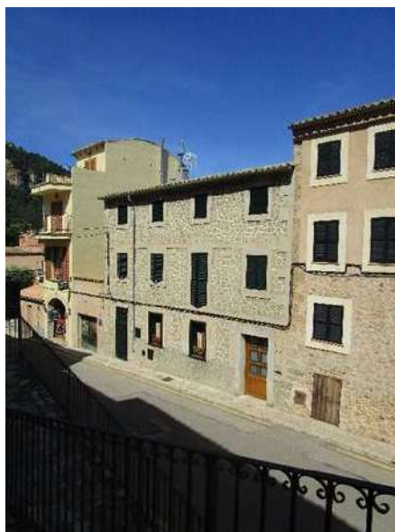
Façana encarada a sud-est
