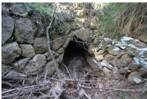
Coberta de dues lloses a doble vessant
