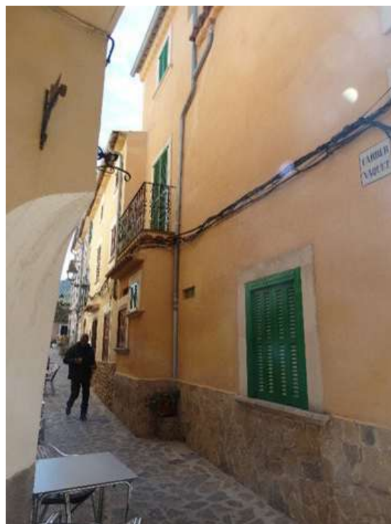
Façana nord-oest amb el balcó
