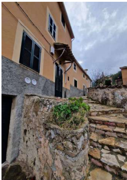
Façana principal amb el voladís
