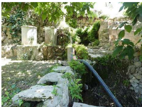
Dipòsit de fibrociment
