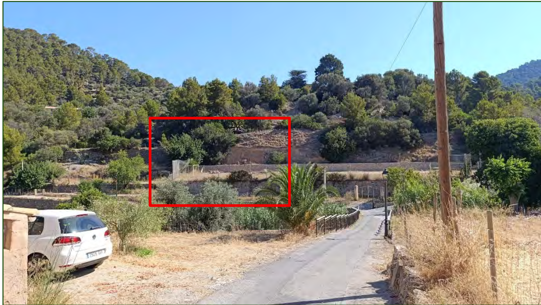
Fotografies 33: Emplaçament de la nova EDAR. Punt 10. Font: ACC 2025.
