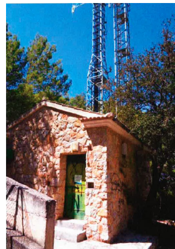
Torre telecomunicacions en sòl rústic, a prop de la MA-10.
